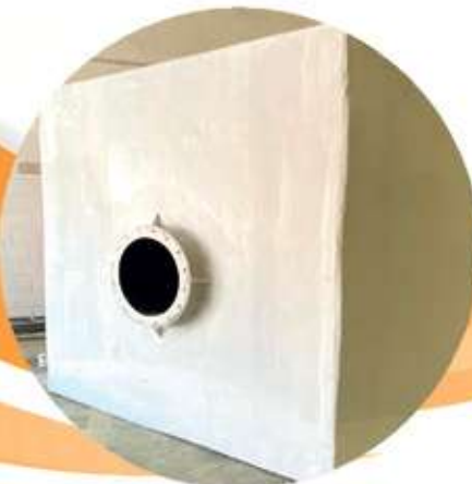
FABRICACIÓN DE DEPÓSITOS IN SITU
