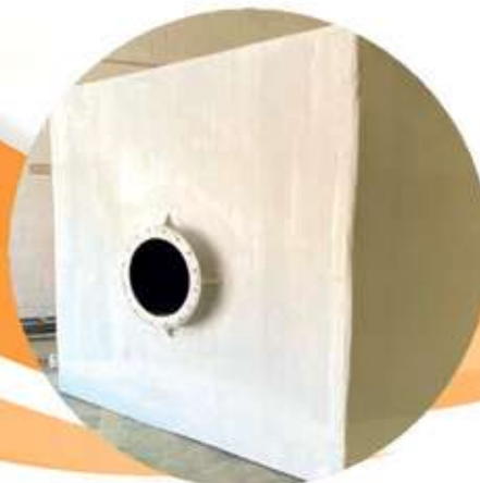
FABRICACIÓN DE DEPÓSITOS IN SITU
